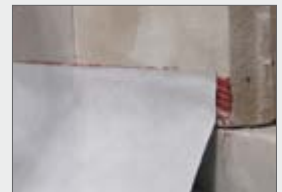
Verblendmauerwerk aufmauern und ELMCO–Sperrfolie-Vlies einlegen
