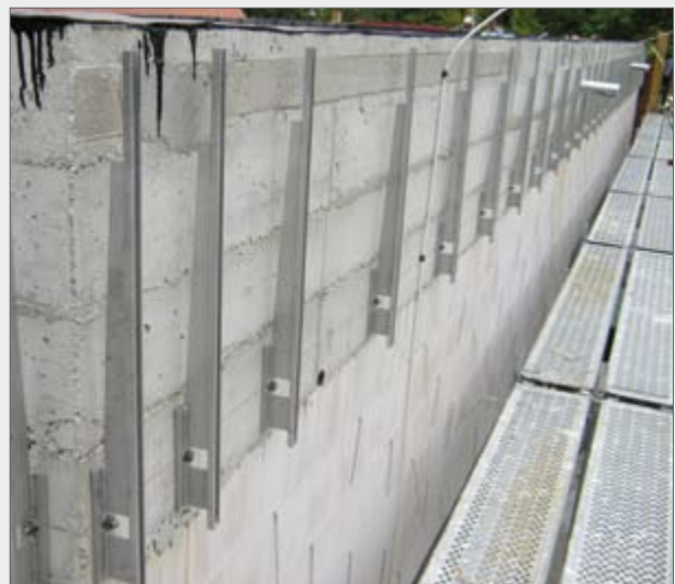
Die Attika-Verankerung ELMCO–AV wird unterhalb des Gleit- lagers am Ringbalken befestigt und trennt auf diese Weise Verblendschale und Flachdach. → Seite 61
