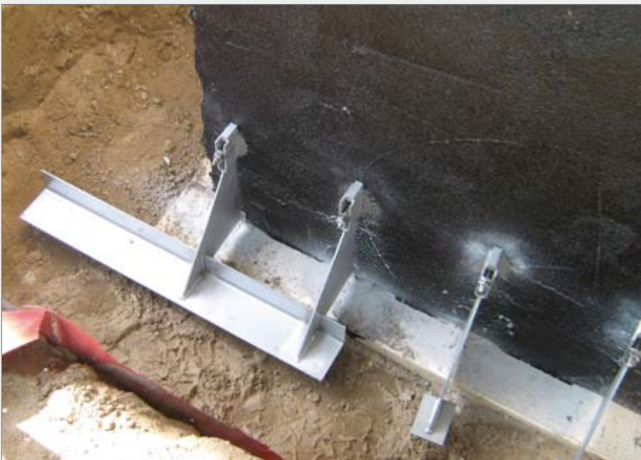
ELMCO–KV-GA-Eck → Seite 47 kombiniert mit ELMCO–KV-GA → Seite 30 als Eckausführung am Fußpunkt
