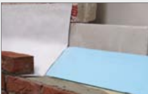
ELMCO–Sperrfolie-Vlies, geprüfte Befestigung am Hintermauerwerk
