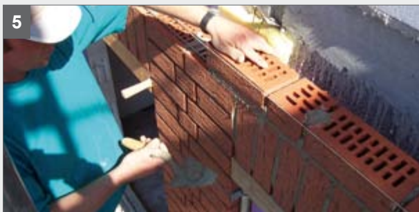
Läuferschichte über dem Grenadiersturz mauern
