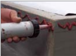
ELMCO–Sperrfolienkleber wellenförmig auftragen, 600 ml reichen für ca. 10 m
