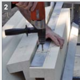
2 Vorbohren der Löcher für die Sicherungsschrauben mittels Bohrschablone
