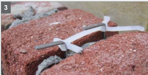
Der weiße Abstandhalter am Unterbügel gewährleistet einen fluchtgerechten Einbau des ELMCO–Ripp-Tragelementes.
