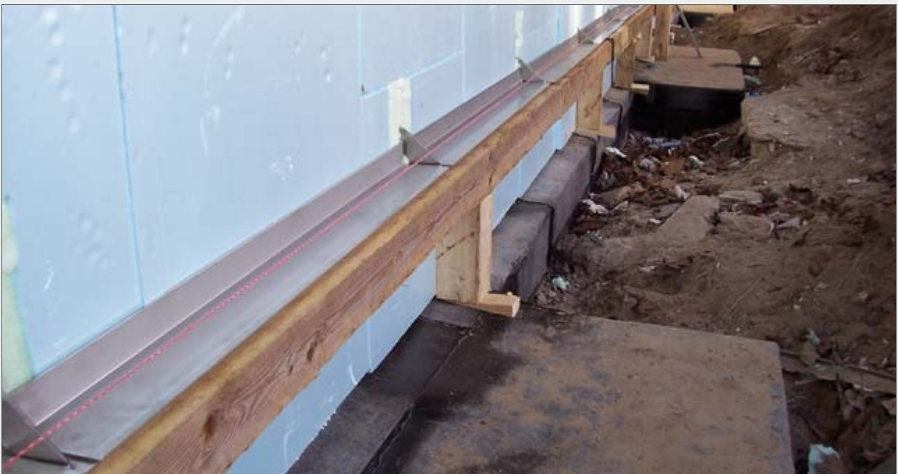
ELMCO–KV-GA → Seite 30 mit aufgelegten Überbrückungswinkeln ELMCO–ÜW → Seite 36
