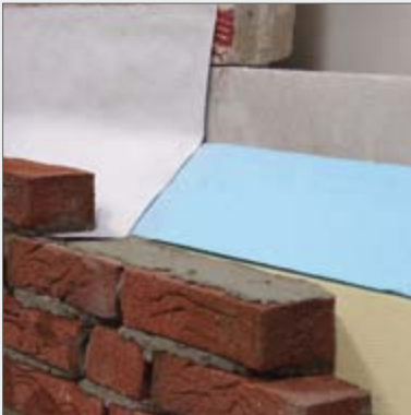
Sperrfolie-Vlies, befestigt mit Kleber "NB"
