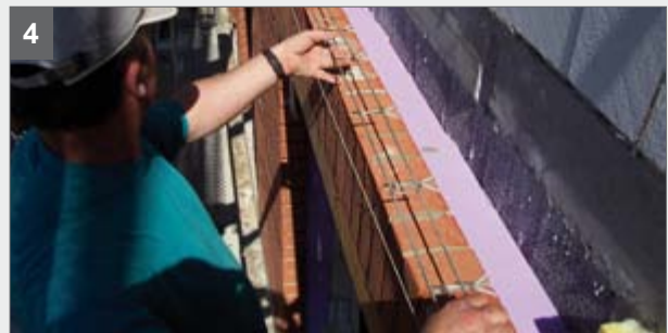
Tragelement von vorn in die beiden offenen Enden der Unterbügel einschieben
