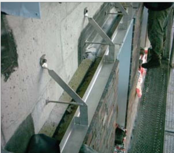
Individuelle Winkelkonstruktion ELMCO–WS mit 2 Anker- punkten Ausführung 4F 45° → Seite 38
