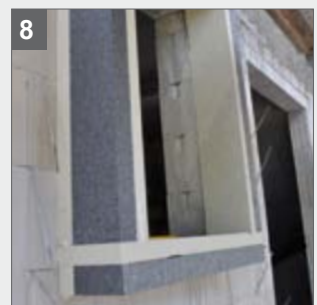
8 Bei Bedarf mit Dämmblock versehen
