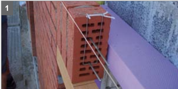
Grenadiere mit Vernadelung mauern, dabei alle 25 cm einen Unterbügel einbauen
