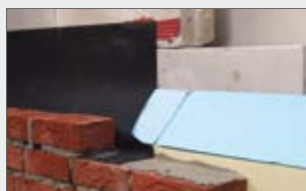
Verklebt am Hintermauerwerk aus KS mit dem ELMCO–Sperrfolienkleber-NB
