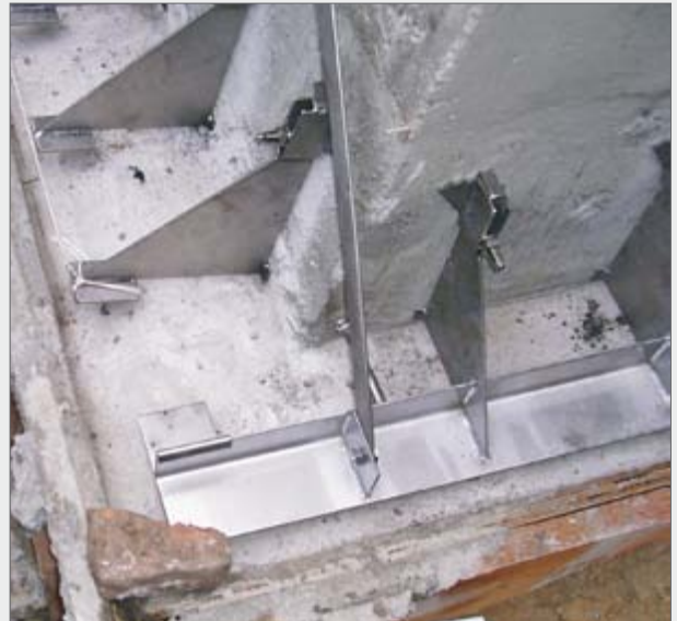
Baustellenbeispiel ELMCO-KV-GA - Eck, Auskragung links, kombiniert mit aufgestecktem Eckschiebling
