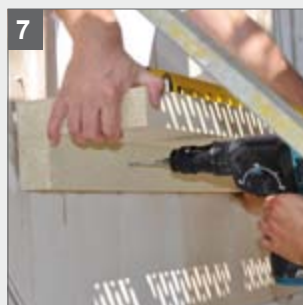
7 Sichern aller Zargen mit Rahmenschrauben gegen Abrutschen
