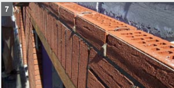
Der Oberbügel sollte in die nächste Lagerfuge hineinreichen.
