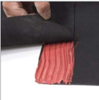
Sperrfolie-EPDM, Stoßverklebung mit Kleber "NB"
