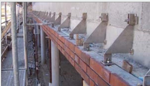
ELMCO-KV-FT-ES-SK mit Versatz, Laststufe 10,5 kN
