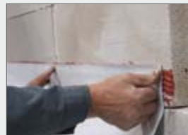
ELMCO–Sperrfolie-Vlies in den Kleber drücken und zusätzlich mit einer Andrückrolle fixieren
