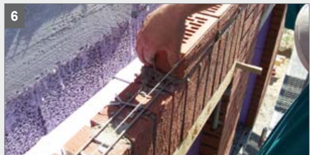
Alle 25 cm einen oberen Klemmbügel in das Tragelement einbauen, den Bügel dabei etwas zusammendrücken
