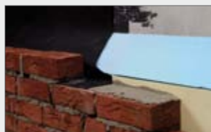
Verklebt auf bituminösem Untergrund mit dem ELMCO–Sperrfolienkleber-BV
