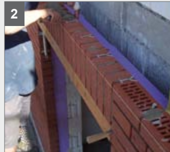
Um den letzten Grenadier im Sturz zu setzen, wird der Stein wie abgebildet eingeschlitz.
