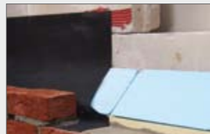
ELMCO–Sperrfolie-EPDM, geprüfte Befestigung am Hintermauerwerk
