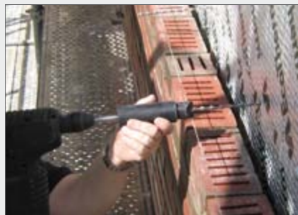
Sanierung: Nachträgliche Verankerung der Verblendsfassade
