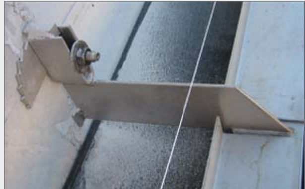
ELMCO–KV-GA als Sonderausführung Laststufe 1,75 kN mit lose aufgelegten Überbrückungswinkeln ELMCO–ÜW
