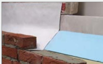
ELMCO–Sperrfolie-Vlies, geprüfte Befestigung am Hintermauerwerk 1
